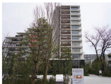
◀校舎跡地には、マンションが建っています。
